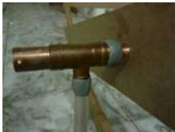
Figura 9. Conector TE de redução.
