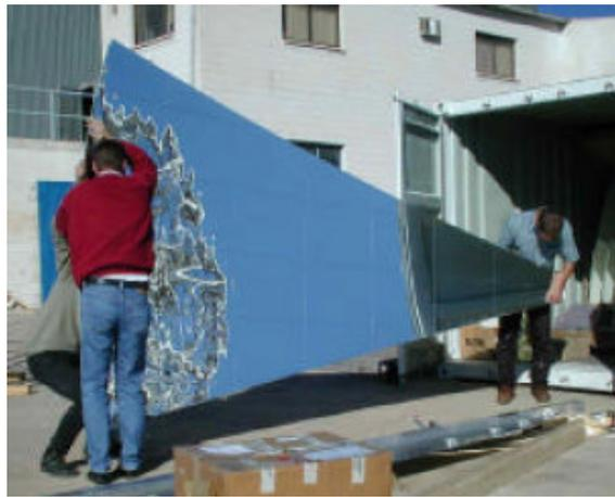
Figura 4. Segmento do coletor parabólico (EuroDish, 2002)
