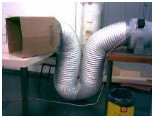
Figura 5. Vista geral do captor, duto e ventilador.
