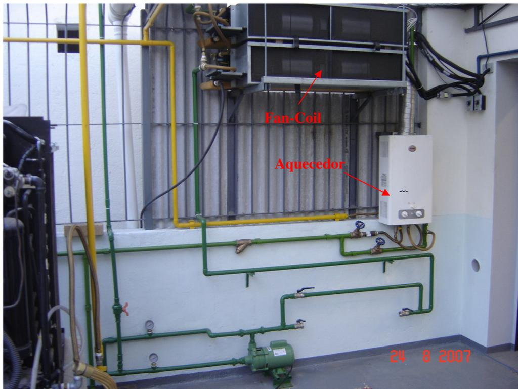
**Fig. 3.2** Simulação da carga térmica: *fan-coil* e aquecedor de água a gás natural
