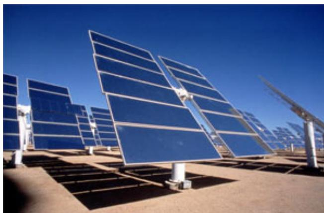
**Fig. 6. 1** – “Heliostats” do sistema de torre de energia.
