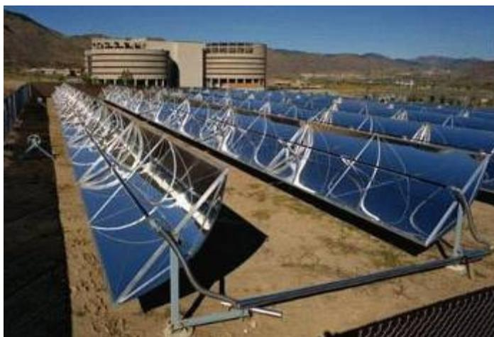
**Fig. 6. 3** – Coletores de calha parabólica.
