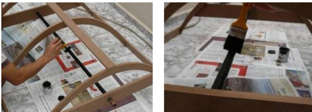
**Fig.14. 13** – Pintura do tubo interno receptor
