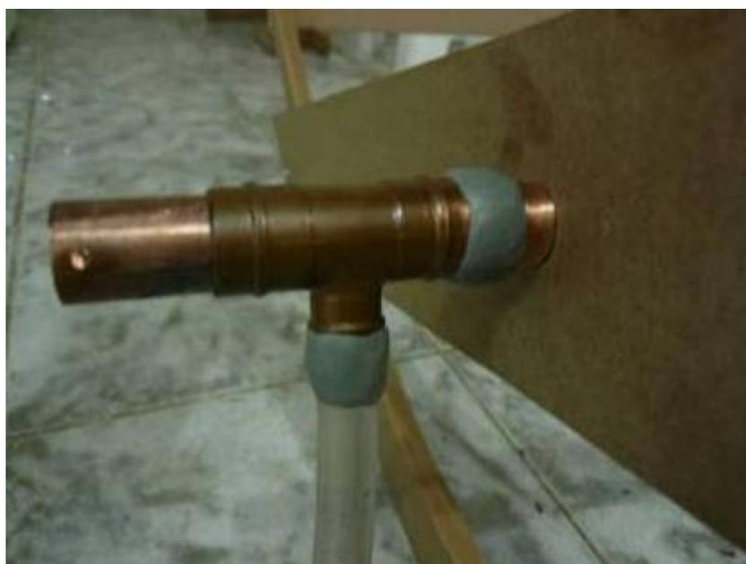
**Fig.14. 16** – TE de redução com vedação de durepoxi.
