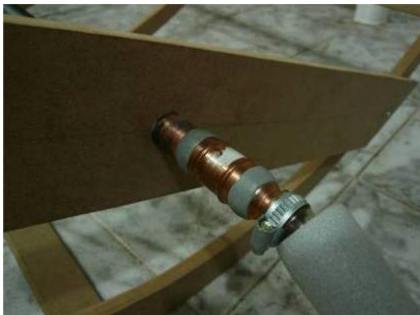
**Fig.14. 17** – Bucha de redução e luva passante com vedação de durepoxi.
