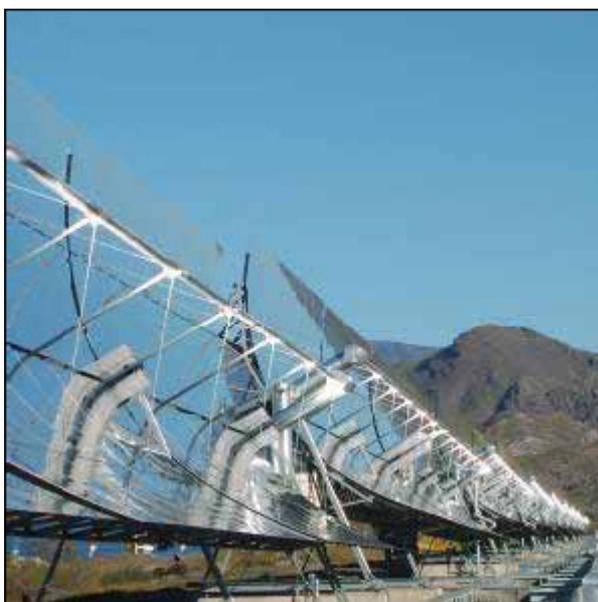
**Fig. 7. 1** – Coletores de calha parabólica.
