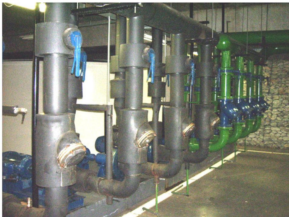
**Figura 3. Bombas de água gelada e água de condensação**
