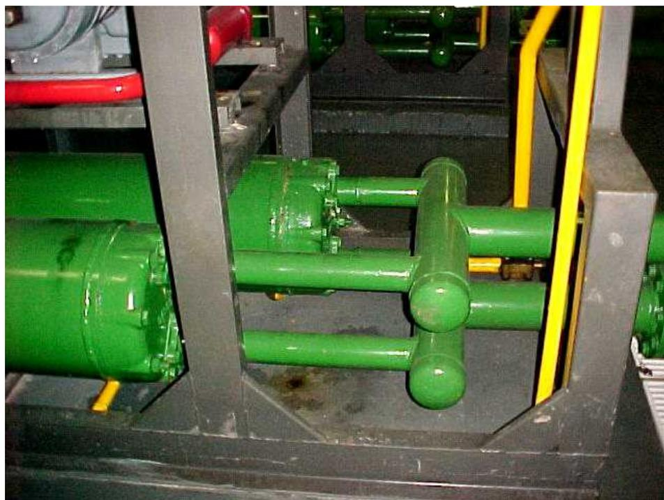
**Figura 10. Condensador do tipo casco tubo**
