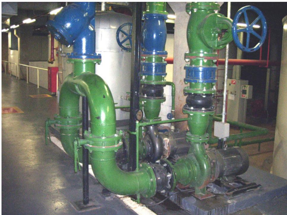
**Figura 14. Bombas da água de condensação**
