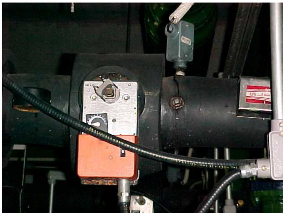
**Figura 6. Válvula "on-off" de bloqueio dos chillers**
