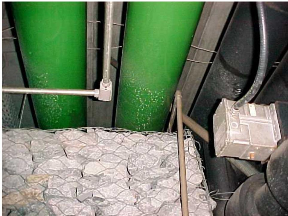
**Figura 8. Válvula pressostática**
