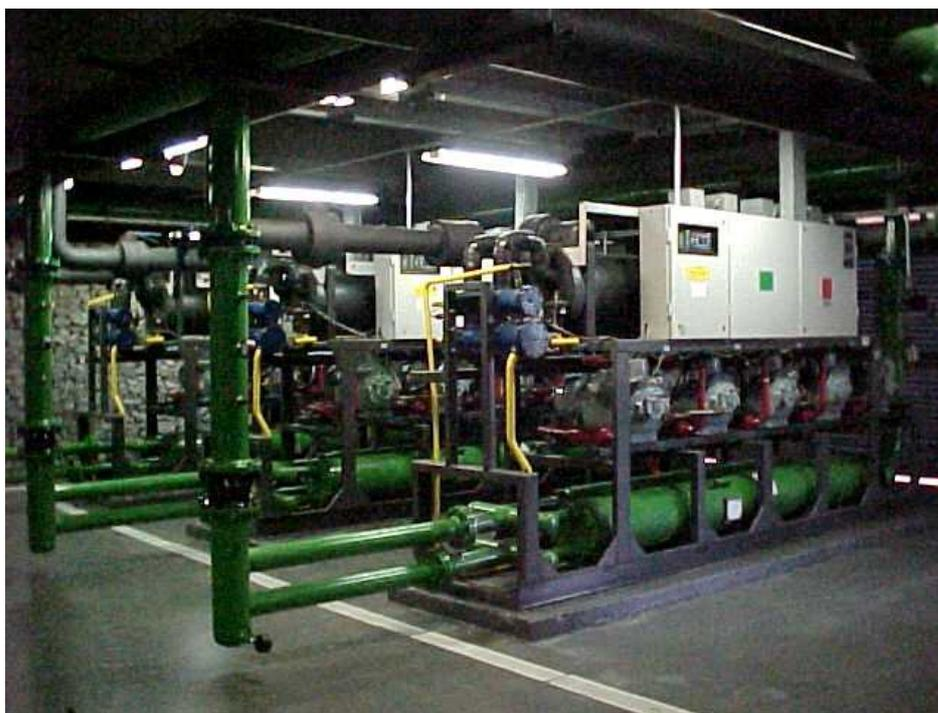
**Figura 2. Resfriadores de água gelada com condensação a água**
