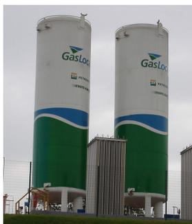
Figura 4. Tanques de armazenagem de GNL.
