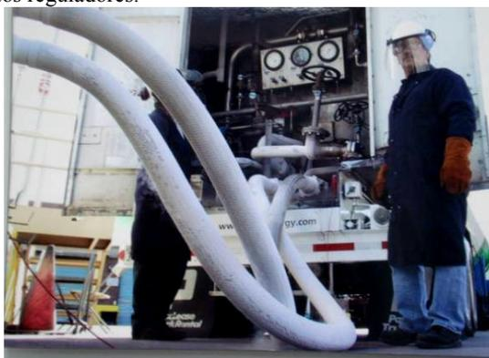
Figura 3. Abastecimento do reservatório de GNL através do caminhão
