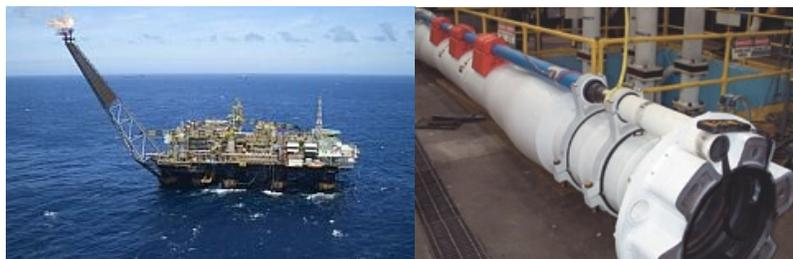
Figura 1 - À esquerda, plataforma P-40, semelhante à plataforma P-17, e à direita, riser fabricado em fibra de carbono.
