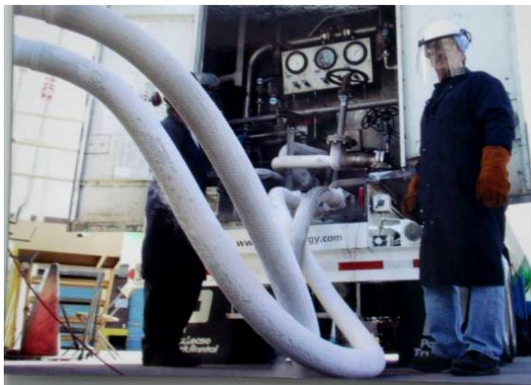
Figura 14. Abastecimento do reservatório de GNL através do caminhão
