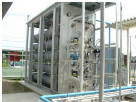
Figura 22. Unidade de armazenamento de GNC
