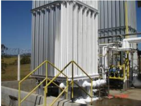
**Figura 3.7** - Vaporizadores atmosféricos, (planta de regaseificação em Andradadas, MG, 2007).
