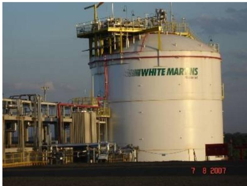
**Figura 2:** Tanque de armazenamento de GNL da planta de liquefação de Paulínia.
