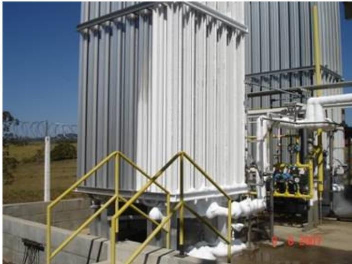
**Figura 4:** Vaporizador do terminal de regaseificação de Andradas.
