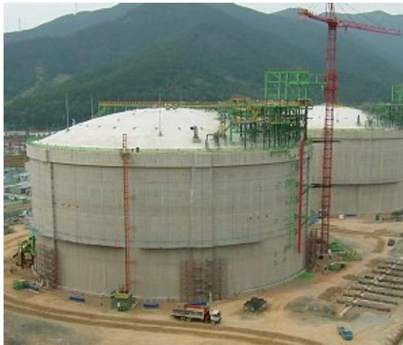
**Figura 2.5** - Tanque de superfície (sistema “aboveground”) desenvolvido pela empresa KOGAS-Tech. (2006)
