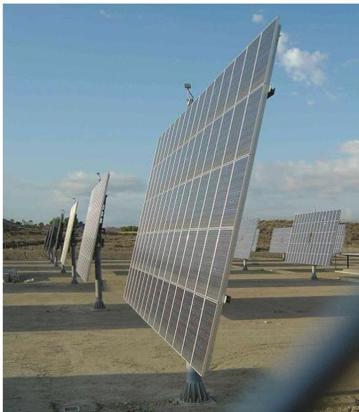
**Figura 3 - Exemplo de seguidor solar com células fotovoltaicas.**
