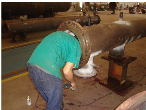
Figura 5 - Inspetor realizando ensaio por Líquido Penetrante
