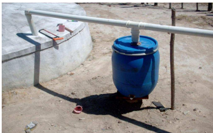
Figura 34 - Bombona (100 L) instalada na tubulação entre cisterna e calha FONTE: Rodrigues (2007)
