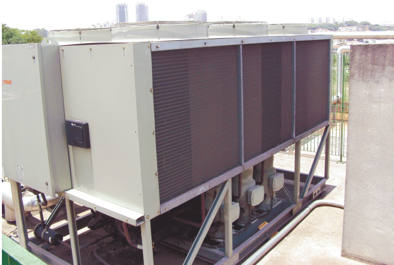
Figura 23: Chiller de compressão de 70 TRs
