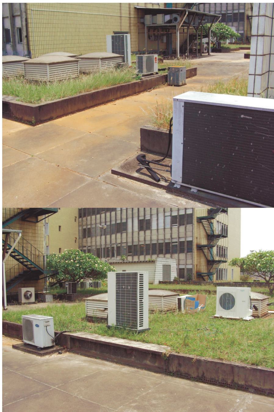
Figura 22: Condensadores no terceiro andar do HU
