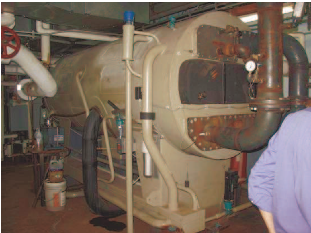
Figura 6: Chiller por absorção
