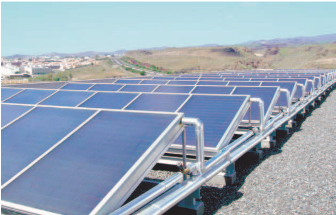
Figura 3: Coletores de uma instalação de refrigeração solar (Fonte: Solar Cooling Recommendations)
