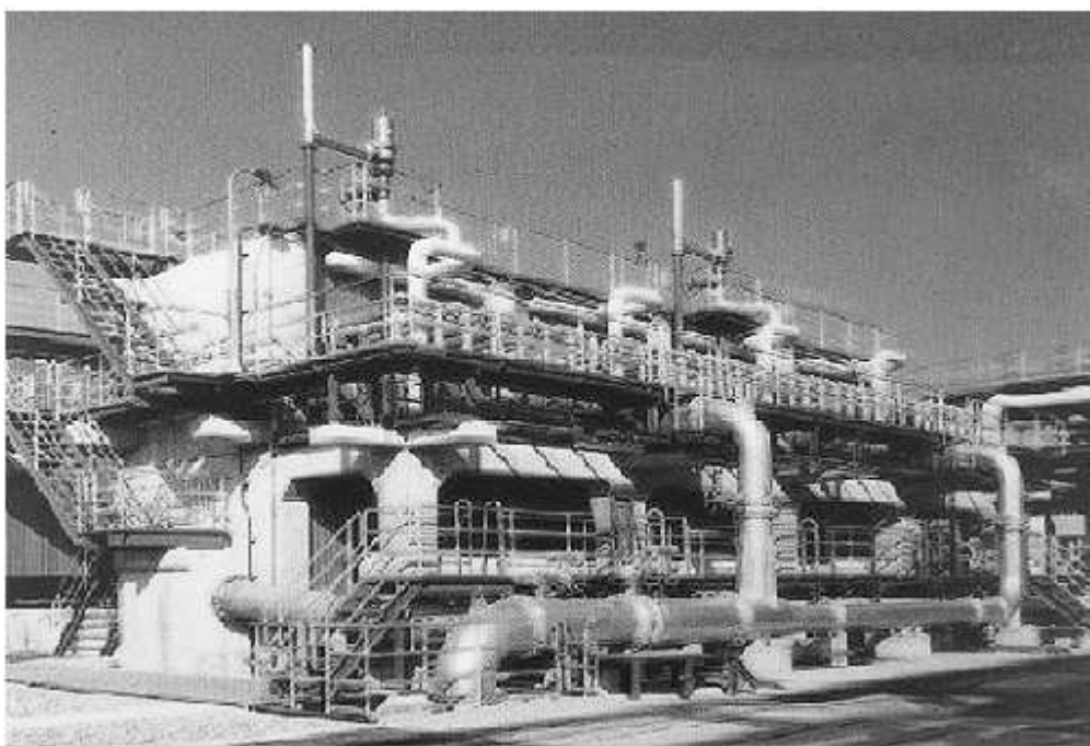
Figura 23 - Open Rack Vaporizer (ORV) Fonte: EPD, Hong Kong
