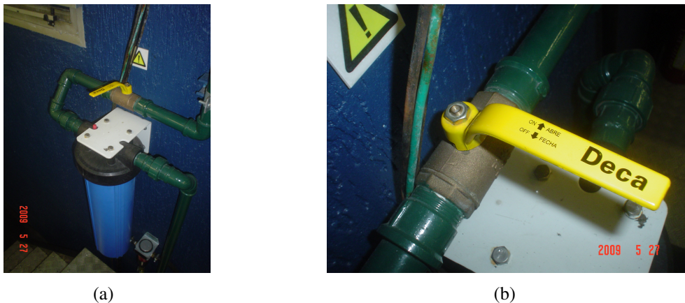
Figura 3.4: (a) Válvula de enchimento do canal (b) detalhe da válvula
