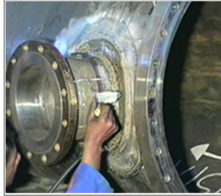
Figura 49 - Teste de estanqueidade em uma conexão
