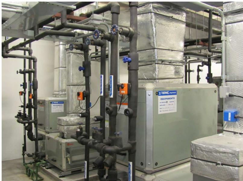
Figura 6 - Condicionadores de ar tipo *fancoil* convencional
