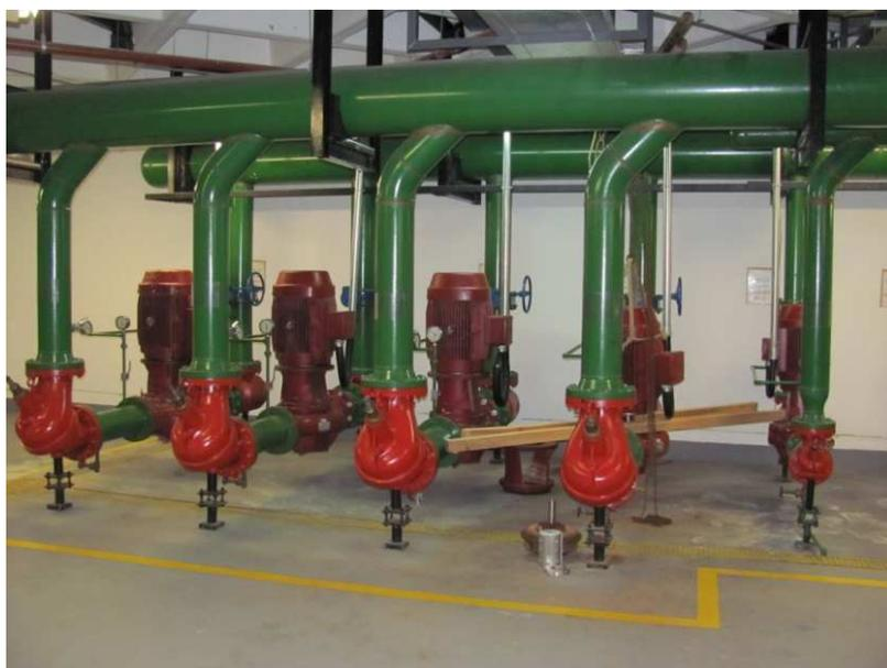
Figura 4 - Bombas de água de condensação
