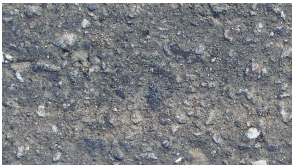
Figura 25 - Textura do pavimento – Ensaio Preliminar
