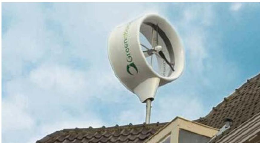
**Figura 2.6 Turbina micro-eólica instalada em uma residência.**
