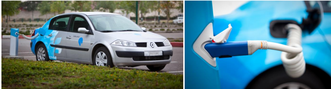
Figura 8 - Estação de recarga de veículos elétricos em Israel.
