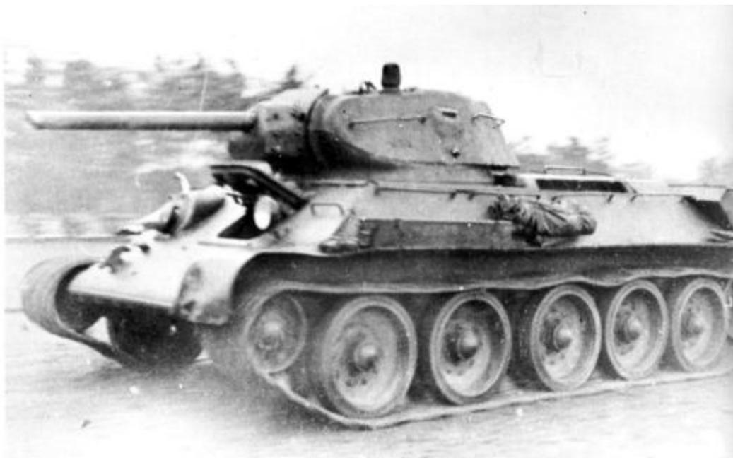
Figura 30: Tanque T-34 Modelo 42, rodas de apoio grandes e sem rodas de retorno. [12]
