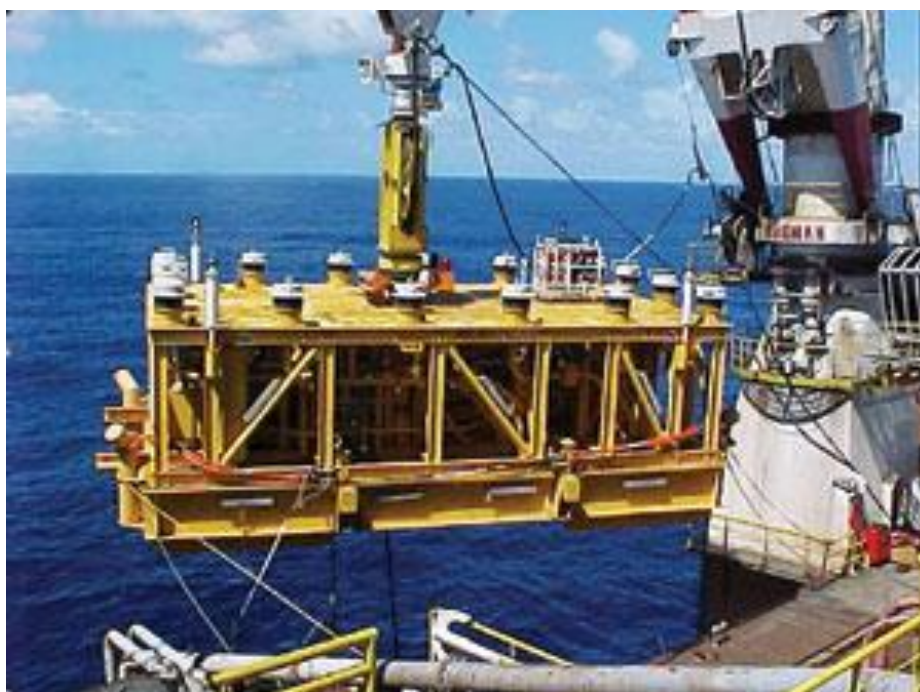
Figura 4. Foto de um manifold sendo lançado para o fundo do mar ( www.offshore-technology.com , 2010).
