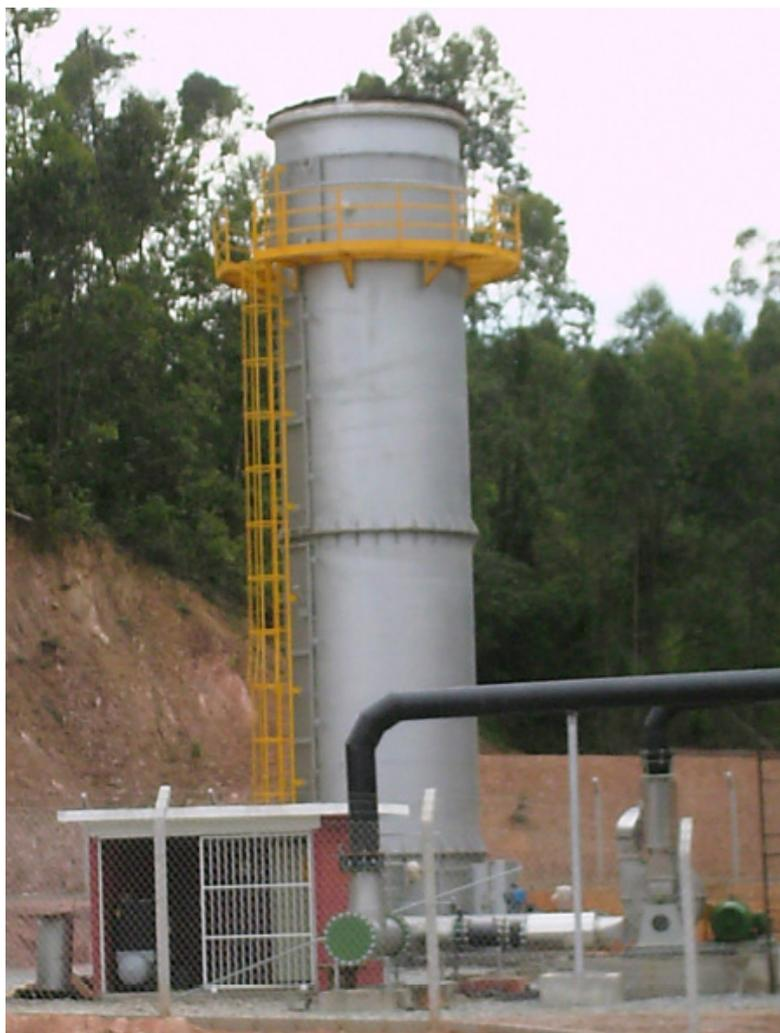
**Figura 3.3** – Tubulação de sucção e *flare* [8].
