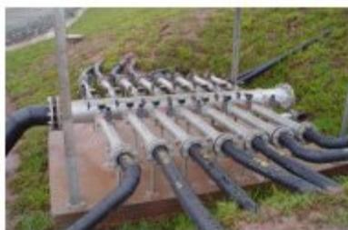
**Figura 3.1** – Rede de tubos coletores de metano. Extraído de [4].
