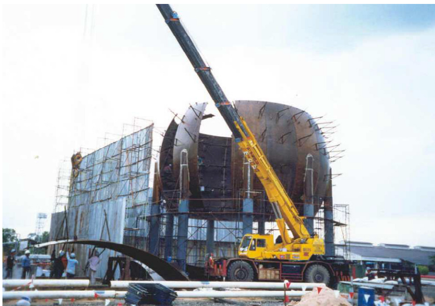
Figura 19 - Fabricação de vaso esférico - fase 2: soldagem dos demais gomos do Equador, seguida pela montagem dos gomos dos trópicos, quando houver (UNIMIT ENGINEERING, 2011).
