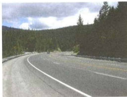
(d) Undivided Rural Multilane Highway Segment
