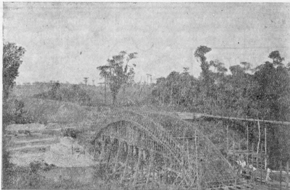
Fig. 2 — Ponte de concreto, em construção, sôbre o Rio do Peixe.
