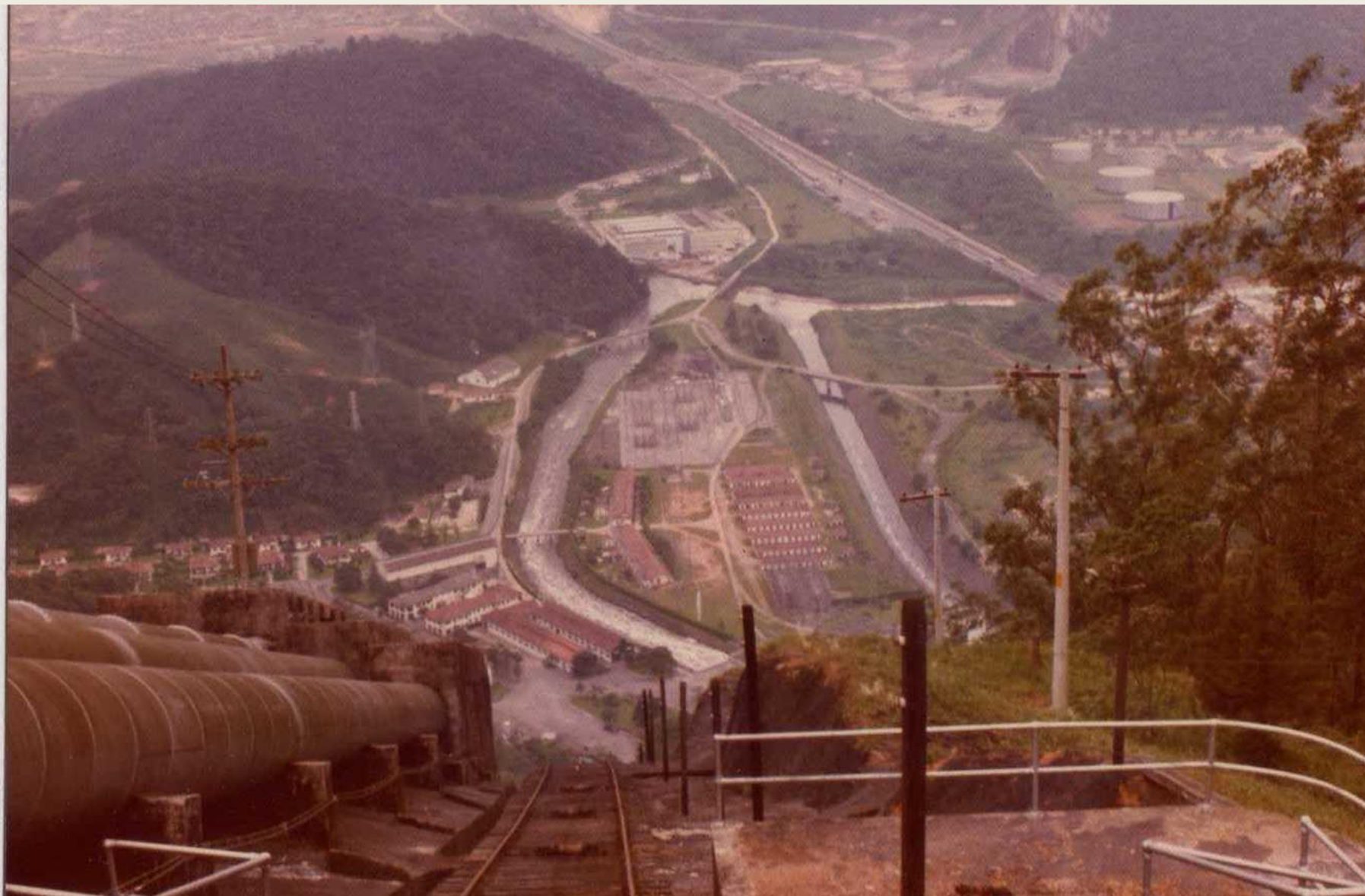
Localização do RESERVATÓRIO INFERIOR: área entre os canais de descarga das usinas externa e subterrânea, com reurbanização e relocação de equipamentos (foto obtida em 1975, em visita ao Sistema Light, vendo-se condutos da Usina Externa à esquerda, canais de fuga , Via Anchieta e acessos)
