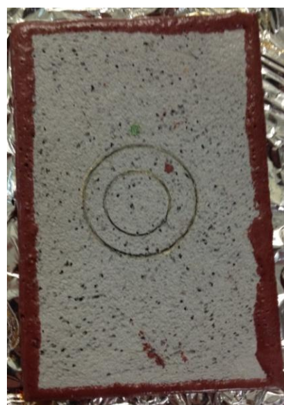
Figura 37. Dano mecânico após choque térmico em placa com revestimento de tinta epóxi
