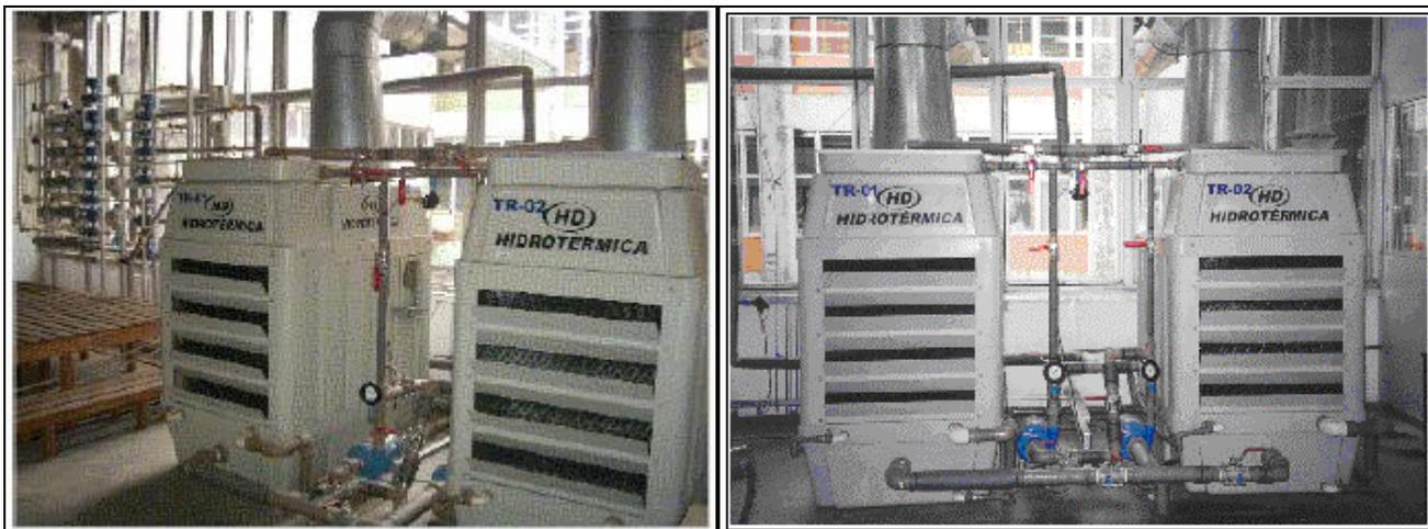
Figura A.2: Torres de Resfriamento TR-01 e TR-02
