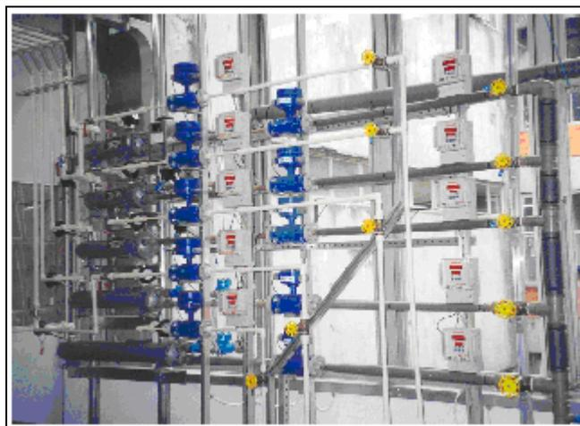
Figura A.4: Malha de Trocadores de Calor TC-01 a TC-05
