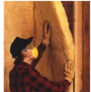
Figura 3: Aplicação de isolamento batt.
