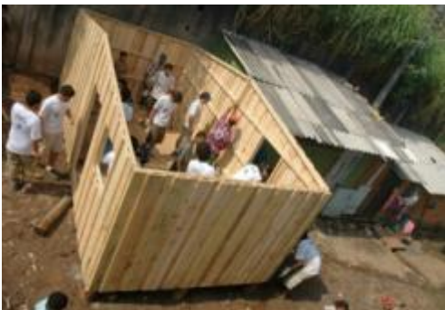
Figura 5. Casa de Emergência em construção pela ONG.
