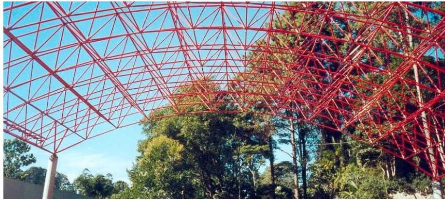
Figura 3.1 – Arco treliçado 3D
