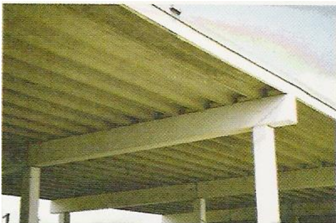
Fig 6.1. Exemplo prático de viga de seção simétrica
