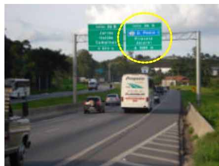
Foto 7 – A mesma placa da Foto 6, instalada no pórtico
