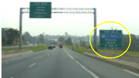
Foto 6 – Exemplo de aplicação da sinalização vertical – placa da direita, no solo
