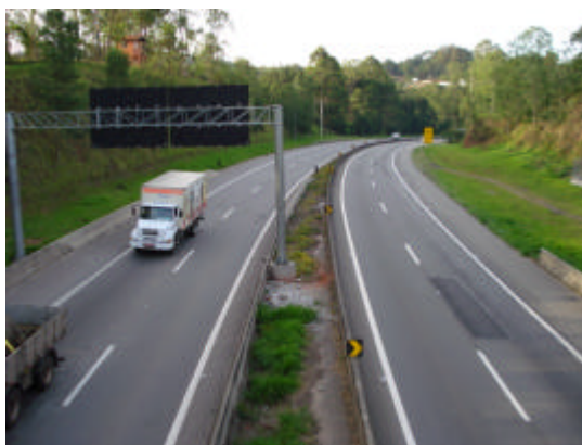
Foto 5 – Visão geral da sinalização horizontal
